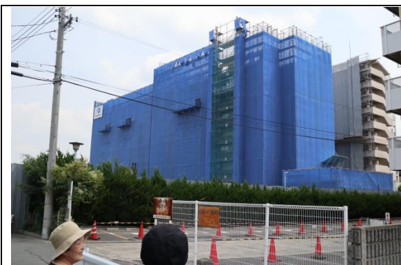
運動場だったところに市営住宅増築中
